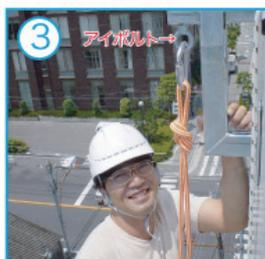
③ 準備が整い次第、下降器を使って下降します。安全機能として、回転しないスチール製アイボルトを採用。
