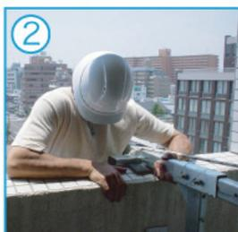
② クランプがきちんとセットされている事を確認し、パラペットにつかまりながら外側へ出ます。パラペットの外側へ出る際は、身体の落下を防ぐ為に必ずアッセンダーや墜落防止器具をライフラインに取付け、自身のハーネスに接続し、安全確保して下さい。
