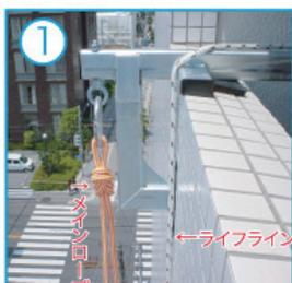
① セットする前に、パラペットそのものの強度・材質などを確認して下さい。念のため、パラペットクランプにも、落下防止措置をとって下さい。クランプは万力のように、パラペットに締め付けます。
