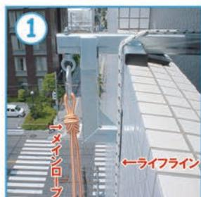
セットする前に、パラペットそのものの強度・材質などを確認して下さい。
