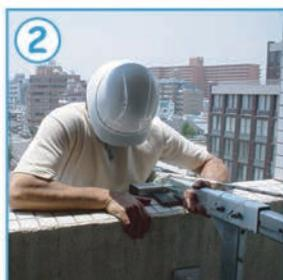
クランプがきちんとセットされている事を確認し、パラペットにつかまりながら外側へ出ます。パラペットの外側へ出る際は、身体の落下を防ぐ為に必ずアッセンダーや墜落防止器具をライフラインに取付け、自身の安全帯やハーネスに接続し、安全確保して下さい。
