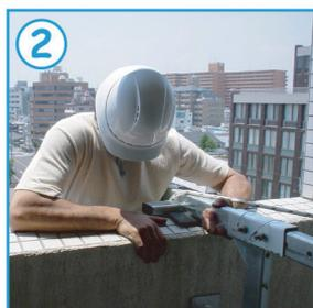
② クランプがきちんとセットされている事を確認し、パラペットにつかまりながら外側へ出ます。パラペットの外側へ出る際は、身体の落下を防ぐ為に必ずアッセンダーや墜落防止器具をライフラインに取付け、自身の安全帯やハーネスに接続し、安全確保して下さい。
