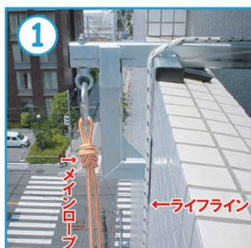
① セットする前に、パラペットそのものの強度・材質などを確認して下さい。
